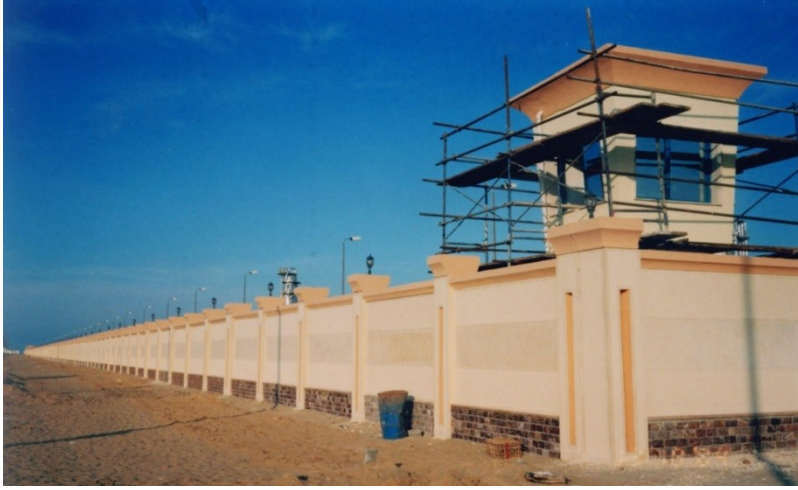
أعمال تشطيبات سور (محطة الشركة المتحدة لمشتقات الغاز بورسعيد)
