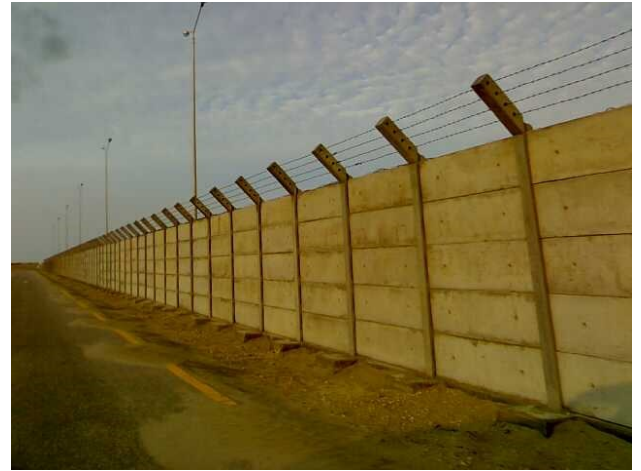
إنشاء سور خرساني سابق الصب (محطة الشركة الأسبانية المصرية للغاز دمياط)
