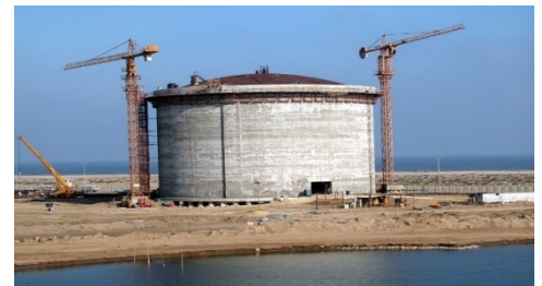
أعمال حدادة خزان محطة ( محطة الشركة المتحدة لمشتقات الغاز دمياط )
