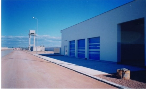
إنشاء مباني ميناء الصيد بالمعدية ( شركة بنتا أوشن اليابانية )
