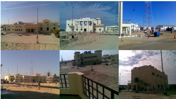
أعمال تشطيبات مباني ( محطة غازات شمال سيناء )
