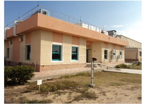
مبنى ضد الانفجار (محطة بتروبل بورسعيد)
