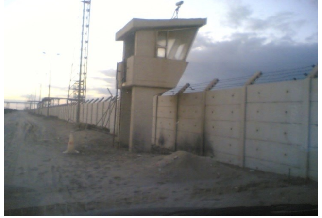
إنشاء سور خرساني سابق الصب (محطة الشركة المتحدة لمشتقات الغاز دمياط)
