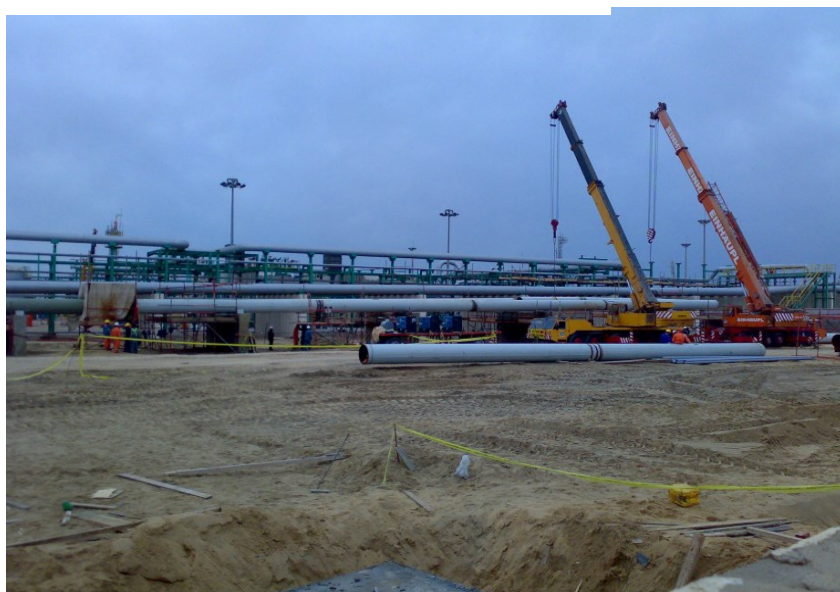
أعمال حاملات وقواعد المواسير ( محطة جابكو بورسعيد )
