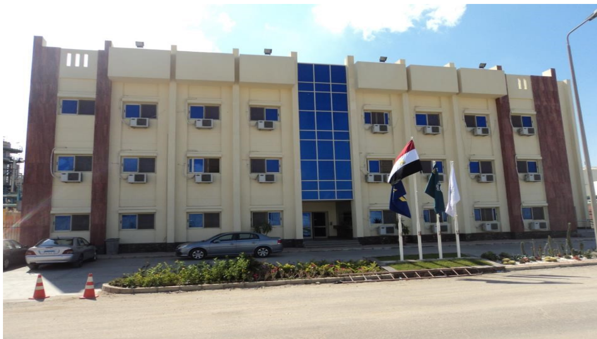
أعمال تشطيبات مبنى الإداري (مشروع موبكو - دمياط)
