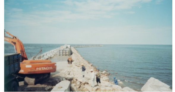
أعمال حواجز أمواج ميناء الصيد بالمعدية ( شركة بنتا أو شن اليابانية )
