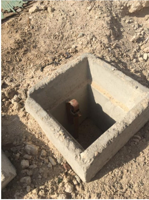
تنفيذ اعمال الحماية من الصواعق لابرار الحراسة لشركة بترول خليج السويس (جابكو)
